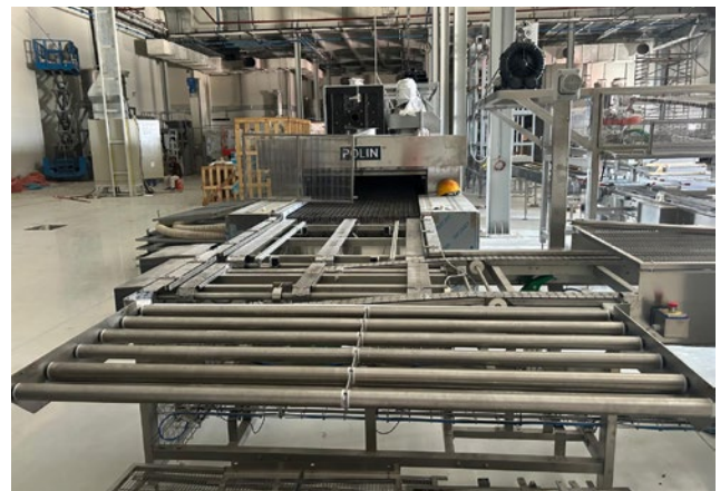
Montaža opreme talijanskoga dobavljača Polin
