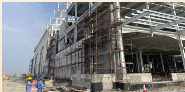
Veličina zgrade pogona – snimljeno prije nešto više od godinu dana
